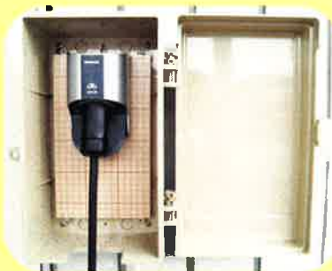
※写真は、基本施設工事+屋外用BOXを設置した状態です。
